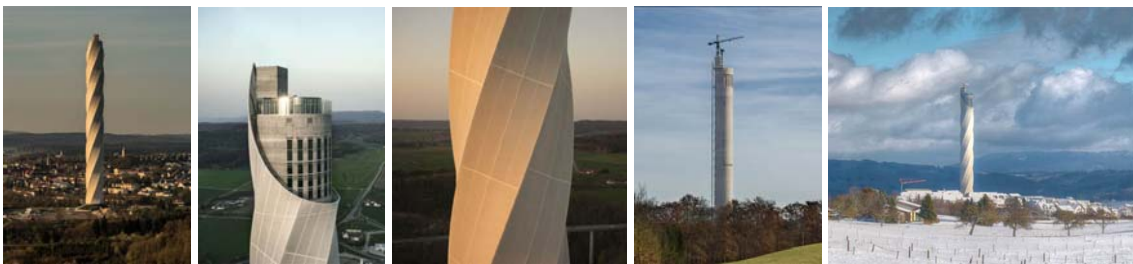
W.Sobek & H.Jahn, 2017: Thyssen Krupp Test Tower, Rottweil
