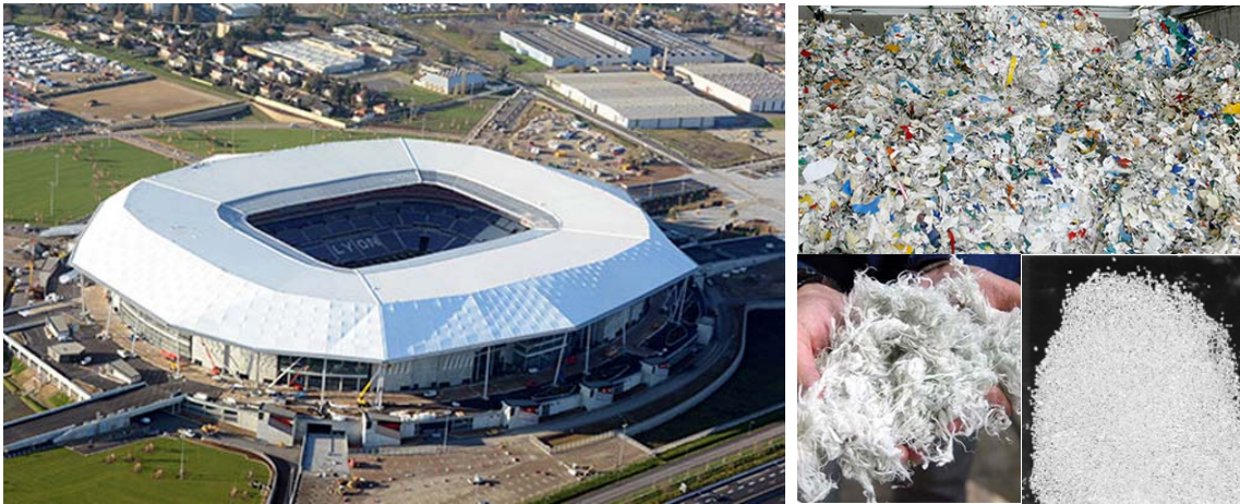
Over 30 000 m 2 of Précontraint TX 30 form the flexible roofing on the Stade des Lumières, Lyon.
