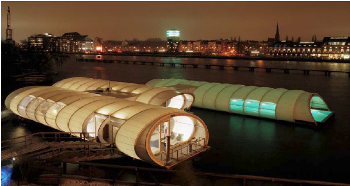
17. “Winterbadeschiff Berlin”, by Dipl.-Ing.Nadine Kannegießer and Dipl.Arch.Gil Wilk TU Berlin, Freier Architekt, Berlin, Germany.
